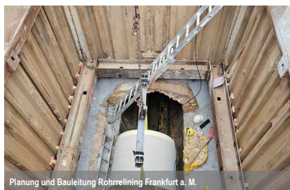
Planung und Bauleitung Rohrrelining Frankfurt a. M.
