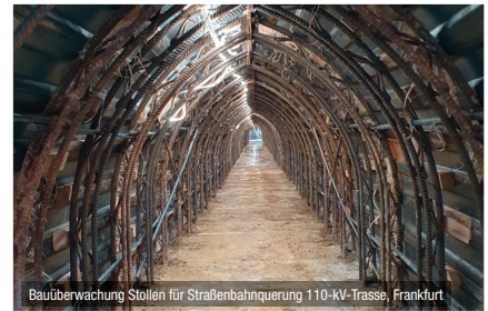
Bauüberwachung Stollen für Straßenbahnquerung 110-kV-Trasse, Frankfurt
