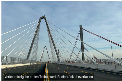
Verkehrsfreigabe erstes Teilbauwerk Rheinbrücke Leverkusen
