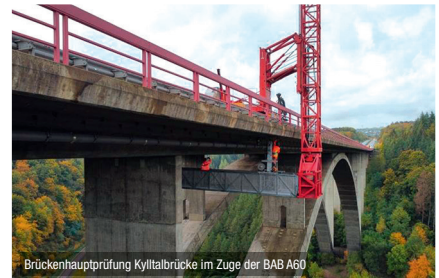
Brückenhauptprüfung Kylltalbrücke im Zuge der BAB A60
