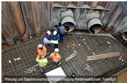
Planung und Bauüberwachung Kanallegung Riederwaldtunnel, Frankfurt
