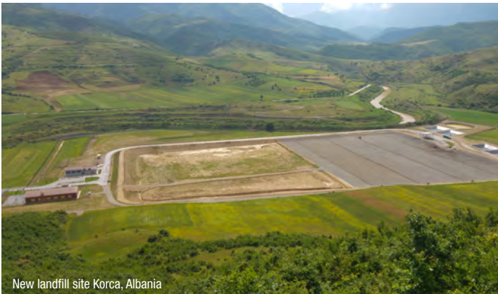
New landfill site Korca, Albania
