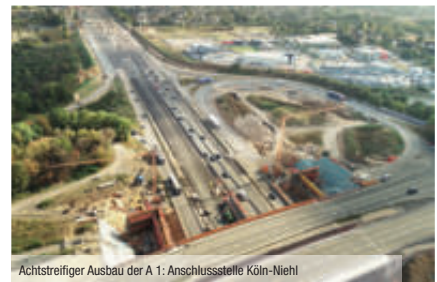
Achtstreifiger Ausbau der A 1: Anschlussstelle Köln-Niehl
