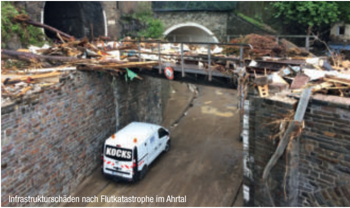
Infrastrukturschäden nach Flutkatastrophe im Ahrtal
