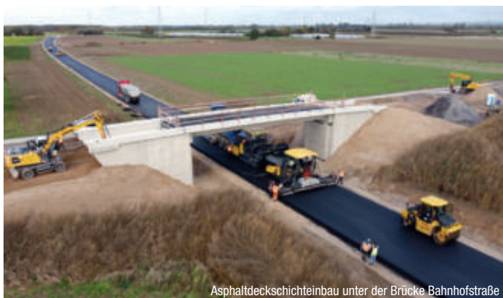
Asphaltdeckschichteinbau unter der Brücke Bahnhofstraße
