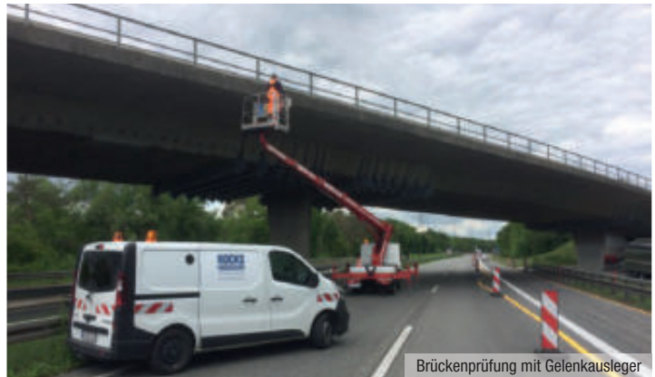
Brückenprüfung mit Gelenkausleger
