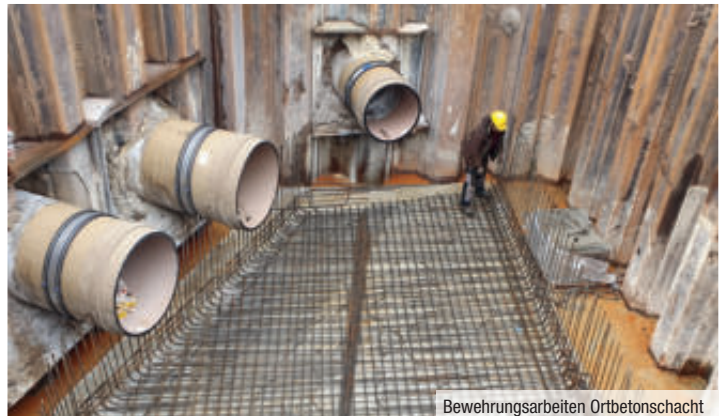
Bewehrungsarbeiten Ortbetonschacht
