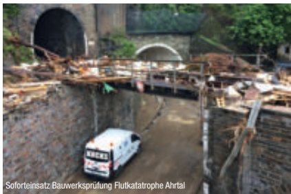
Sofortereinsatz Bauwerksprüfung Flutkatastrophe Ahrtal
