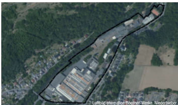
Luftbild ehemalige Boesner-Werke, Niederbieber
